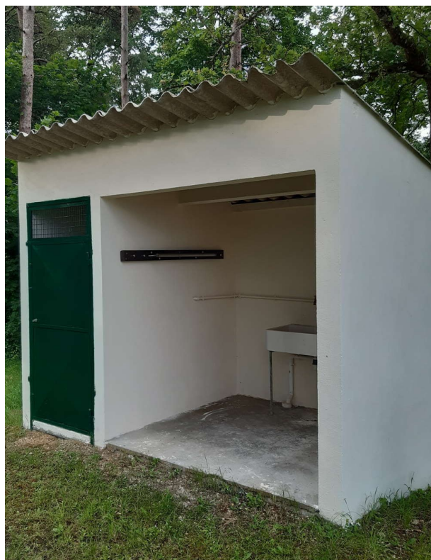
De pratiques petits coins rénovés (château d'eau)
