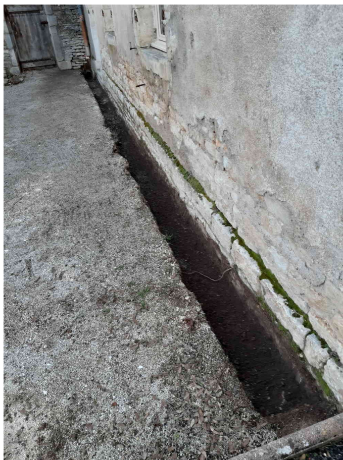
Pose d'un drain dans la cour arrière
