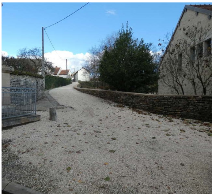
le mur et la ruelle réhabilités
