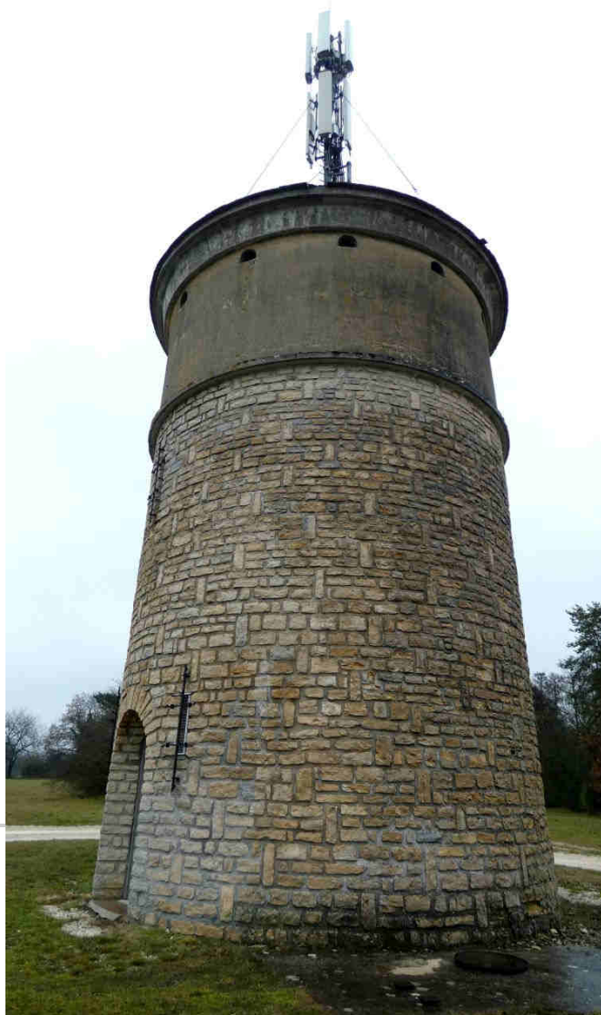
le château d'eau de St-Seine sera restauré
