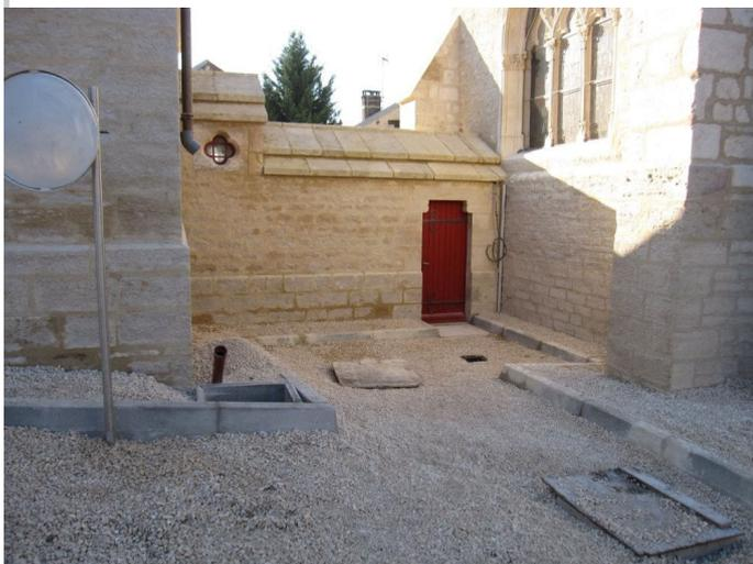
Afin de garantir sa stabilité, l'architecte des monuments de France a préconisé la mise en place d'un enduit projeté et la création d'une ceinture en béton armé en fond de fouille d'assainissement ce qui n'a pas été sans conséquence sur la durée des travaux de cette 3<sup>ème</sup> tranche. Ceux ci devraient être terminés d'ici la fin de l'année.
